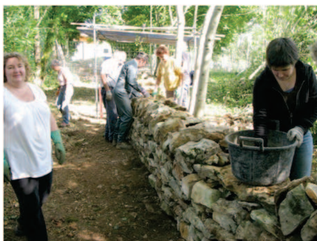
mise en place du couronnement en hérisson
