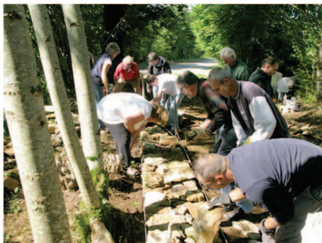
Préparation de l'assise
